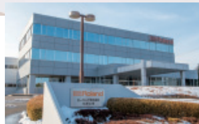
業務用音響・映像関連機器を開発している ローランドの松本工場
