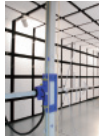
電波測定試験／無線ノイズ試験
